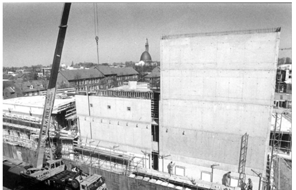
De Leest in aanbouw (WAA71880)
